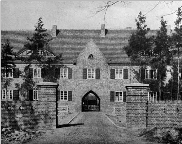
Siedlungseingang Potsdamer Chaussee
