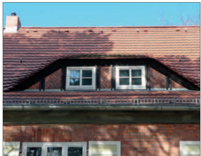
Zweifenstrige Gaube nach Sanierung
