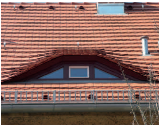
Fledermausgaube nach Sanierung
