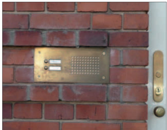
Klingelanlage und Türbeschlag nach Sanierung
