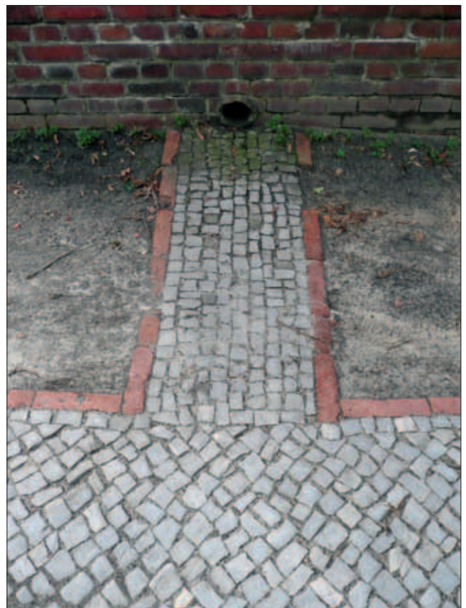
Bauzeitliche Entwässerungsrinne
