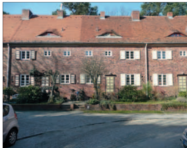
Einfamilienhäuser mit Fledermausgauben
