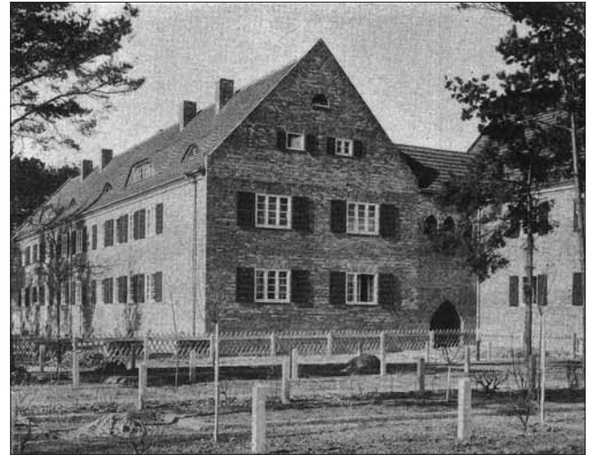
Mehrfamilienhäuser Potsdamer Chaussee
