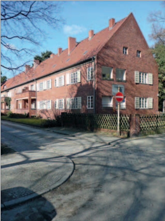
Mehrfamilienhäuser Am Heidehof 51–54
