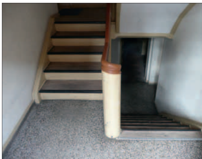
Mehrfamilienhäuser Am Heidehof 51–52: Eingangsbereich mit Terrazzoboden
