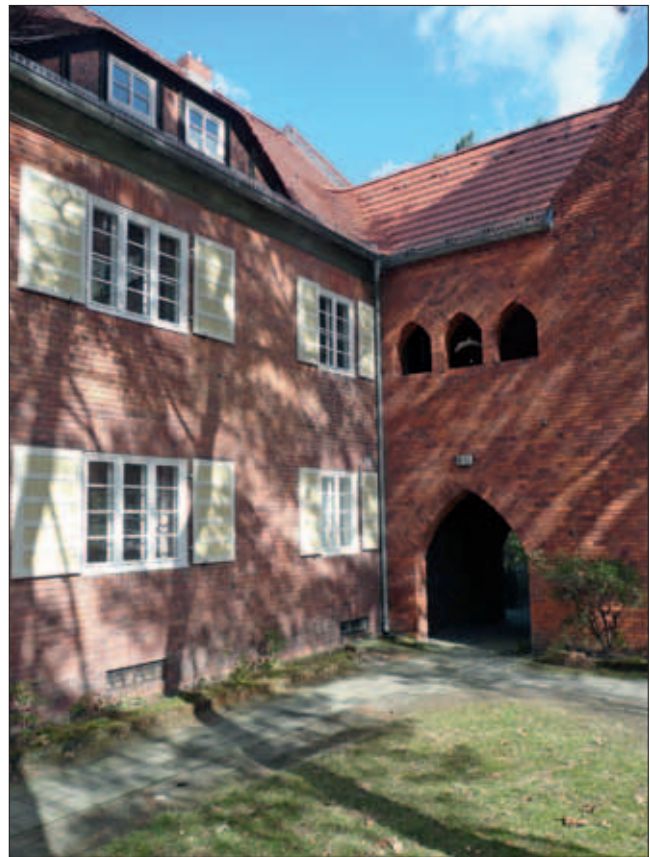
Übergang zweier Dachflächen mit „eingebundener Kehle“
