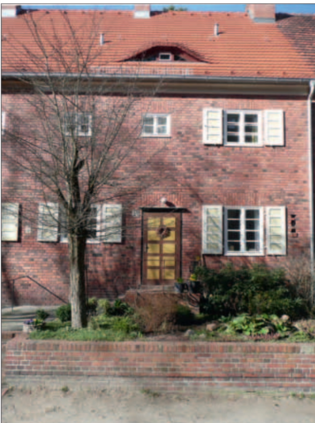
Einfamilienhaus Am Heidehof 40
