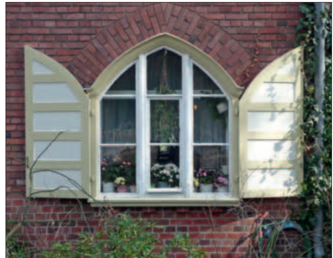
Spitzbogenfenster des ehem. Kaufhauses
